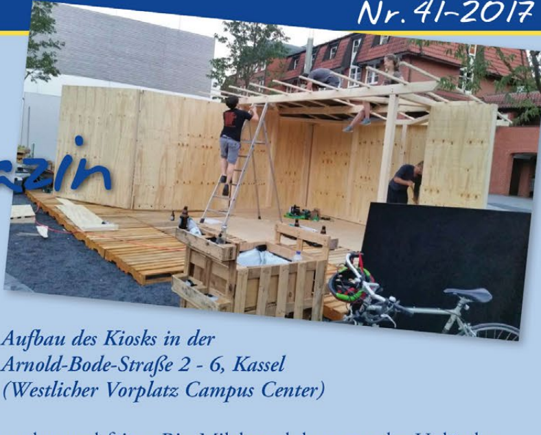
Aufbau des Kiosks in der Arnold-Bode-Straße 2-6, Kassel (Westlicher Vorplatz Campus Center)
