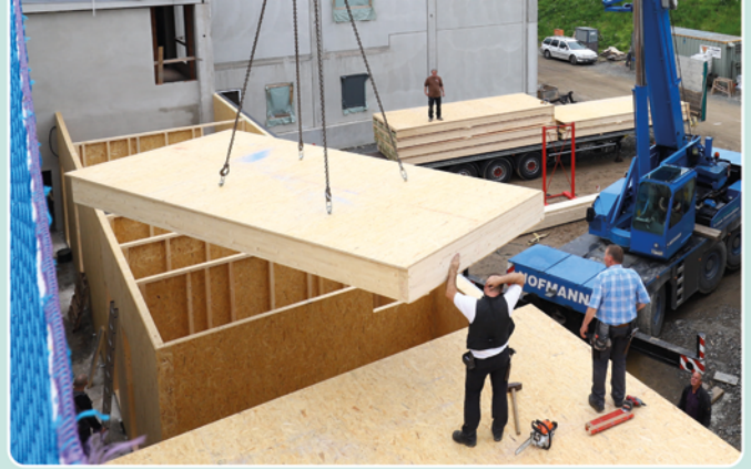
Der Sozialbereich mit Umkleideräumen, Pausenraum und Büros wurde in Holzständerbauweise errichtet.
