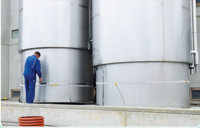
Die ersten Außentanks wurden bereits installiert. Der größte der bisher aufgestellten Tanks hat ein Gesamtvolumen von 80.000 Litern.
