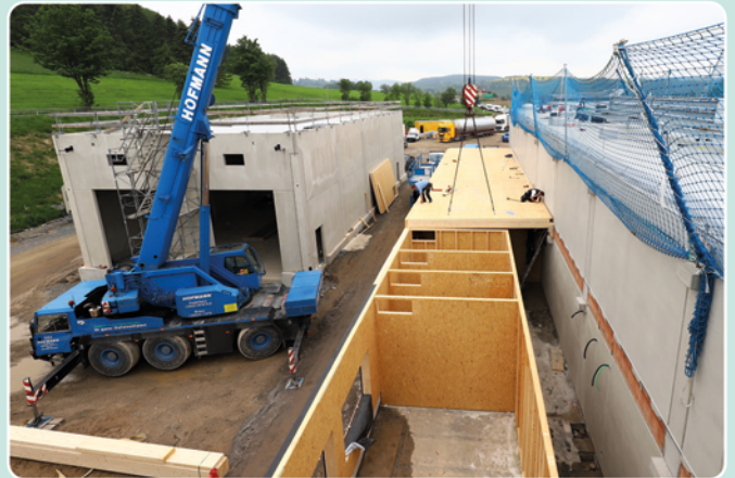
Der Sozialbereich mit Umkleideräumen, Pausenraum und Büros wurde in Holzständerbauweise errichtet.
