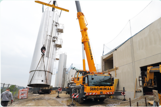
Die ersten Außentanks wurden bereits installiert. Der größte der bisher aufgestellten Tanks hat ein Gesamtvolumen von 80.000 Litern.
